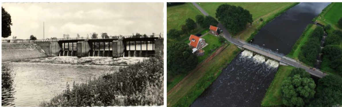
Figuur 3: Archiefphoto stuw Junne (links) en luchtfoto (rechts)
