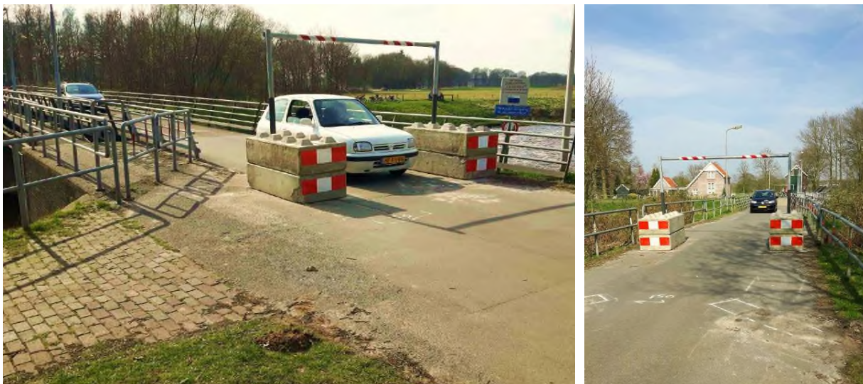
Figuur 2: Huidige fysieke verkeersmaatregelen aan weerszijden van de brug over stuw Junne
